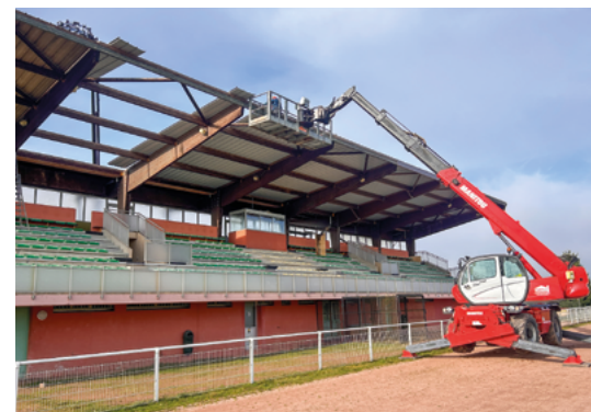
Les tribunes du terrain « Honneur » de rugby ont été consolidées et sont à nouveau accessibles depuis février 2026.
