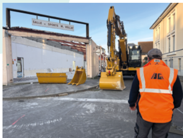
Après la démolition de l'ancien gymnase Vollat, endommagé par la grêle en 2022, la ville a choisi de transformer cette contrainte en opportunité en créant un nouvel espace public végétalisé au cœur de Digoin.
